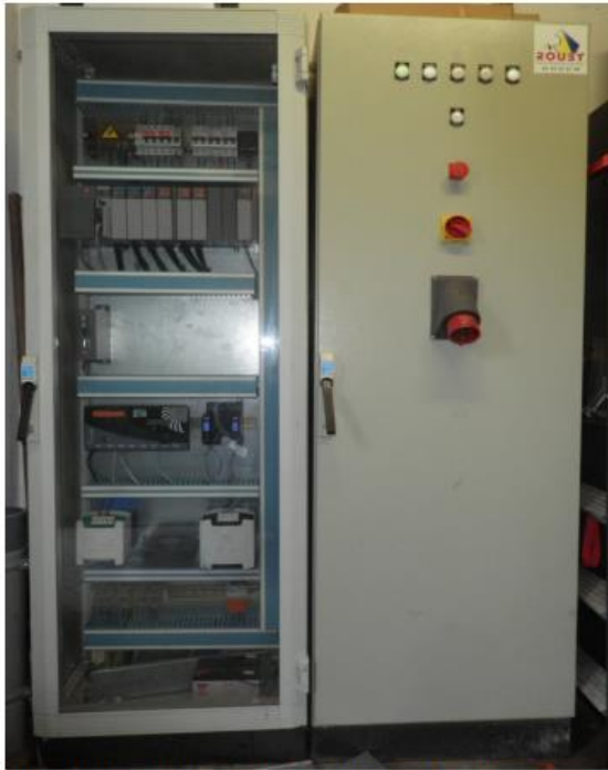
Vue armoire automate (gauche) et TGBT (droite)
